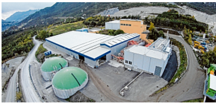
Die Abfallbeseitigungsanlage Roppen sollte bereits in wenigen Wochen auch Biogas für das Netz der Tigas bereitstellen. Foto: ABV Westtirol/Rangger
