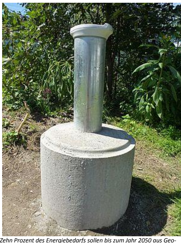
Zehn Prozent des Energiebedarfs sollen bis zum Jahr 2050 aus Geo- und Solarthermie kommen. Sonden wie diese in Bruck am Ziller liefern die Grundlagen für die Nutzung von Grundwasser zum Heizen und Kühlen.
